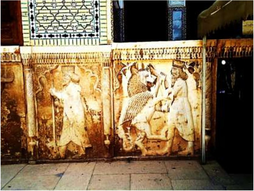
Dış duvar kaplamaları
