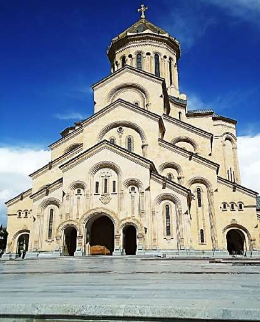
Kilisenin cepheden görünüşü
