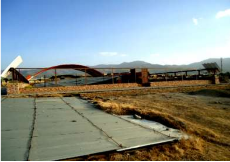
Dairesel bir çatı ile korunan saray kalıntısı.
