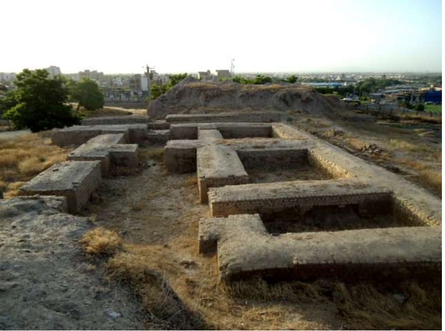
Bir yapı temeli
